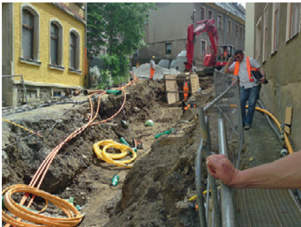
Baumaßnahme Fleischergasse in Annaberg-Buchholz
