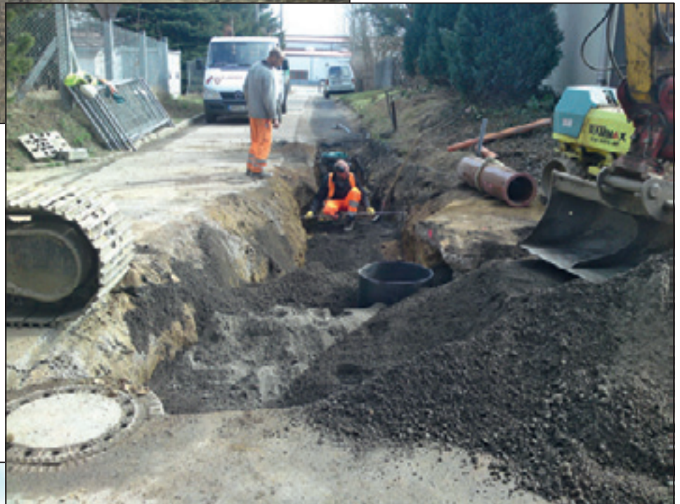
Bauarbeiten Industriestraße in Geyer
