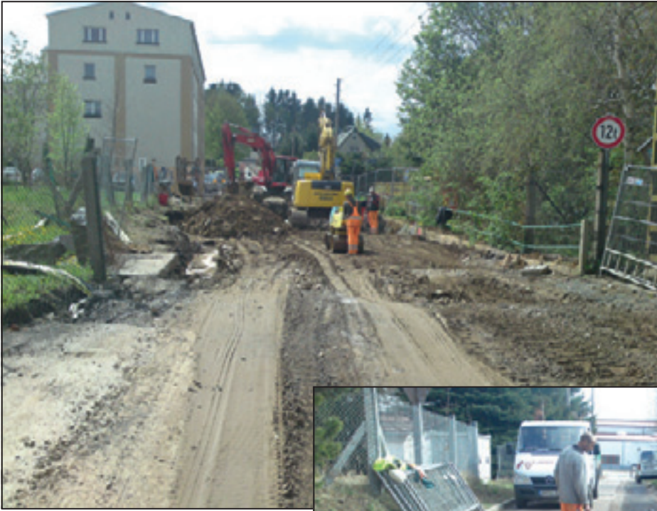
Bauarbeiten Bingeweg in Geyer
