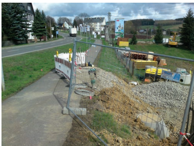
Kanalbau Ortslage Schönfeld
