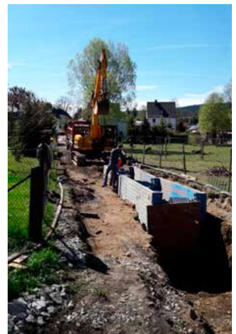
Baubeginn Ortslage Walthersdorf
