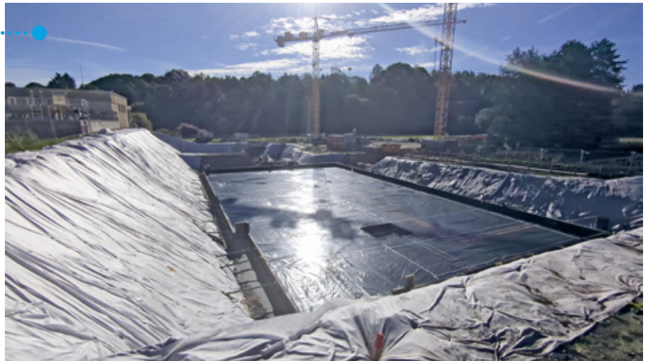
Baugrube zum Neubau Komplexbauwerk Hochlastbelebungs/Vorklärun
