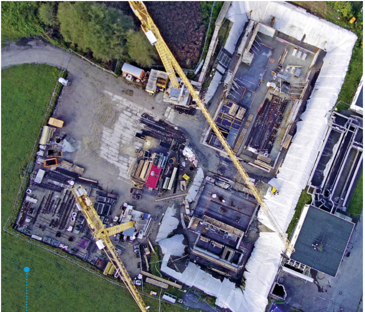
Ausbaustufe mit Blick auf den Neubau des Komplexbauwerkes Hochlastbelebung/Vorklärung sowie des Zulaufbauwerkes
